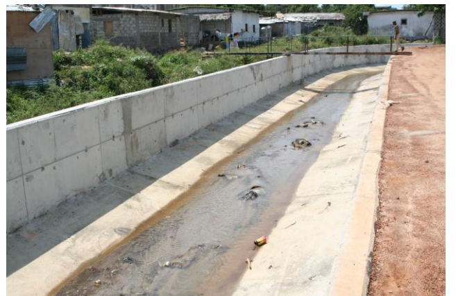
Canal d'évacuation des eaux pluviales en construction
