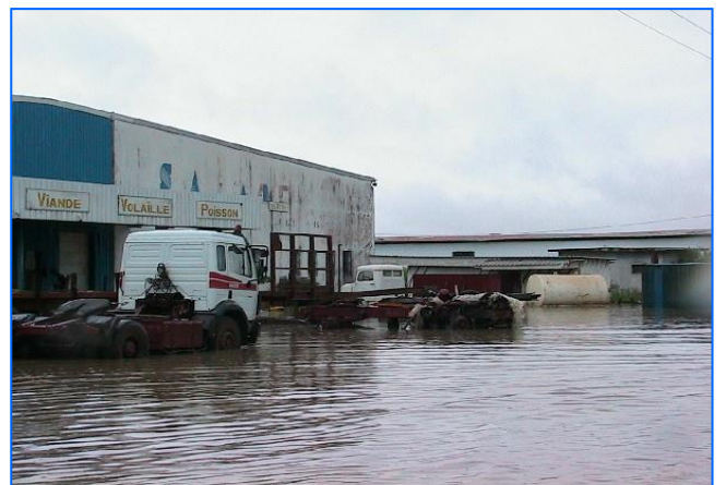
Inondation dans la zone industrielle d'Oloumi
