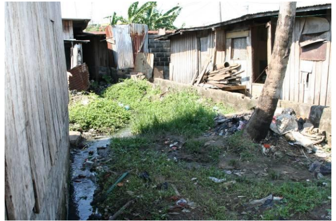
Evacuation des eaux usées
