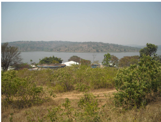
Station de traitement d'eau de Genda – Lac Cyohoha
