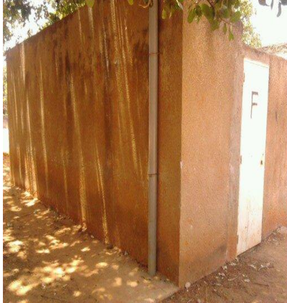
Latrine Publique- Site de démonstration -école (PDAZ)
