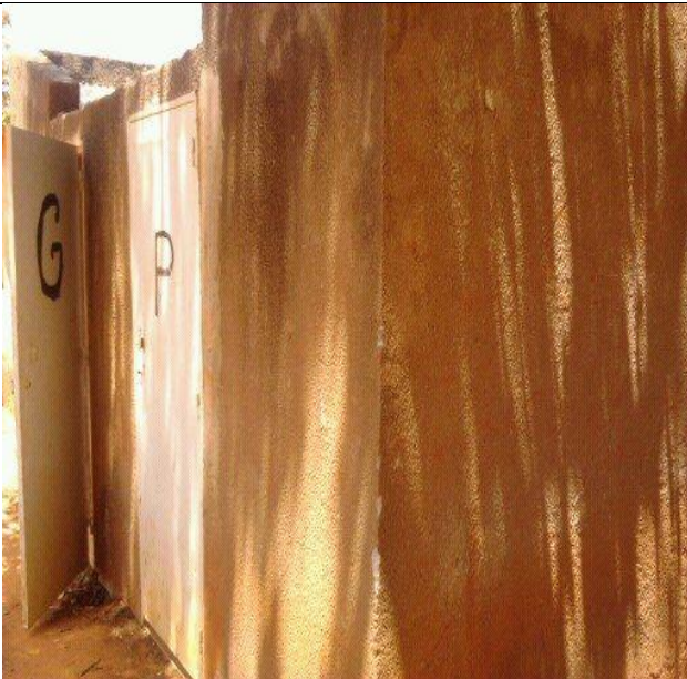
Latrine Publique- Site de démonstration -école (PDAZ)
