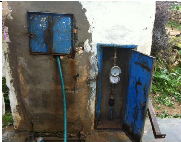
Photo 3 : Compteur d'eau d'une borne fontaine
