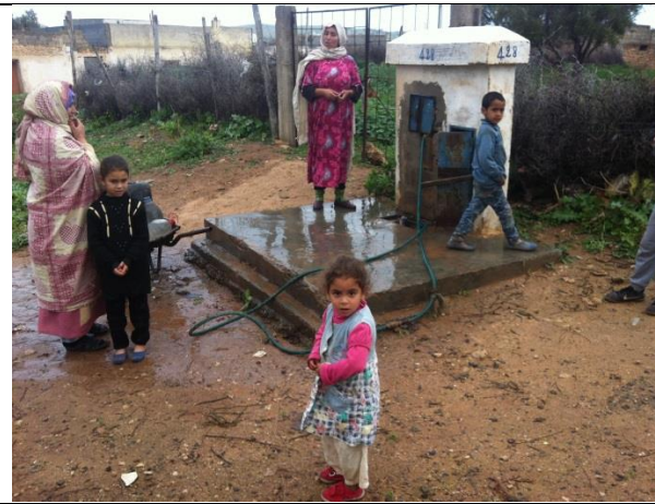
Photo 4 : Douar alimenté par une borne fontaine dans le cadre du programme de généralisation de l'accès à l'eau potable (Safi Ouest, système Sud)
